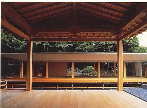
Gambar 16 Struktur lantai sampai atap pada stage of Forest (Beng, 1998)
