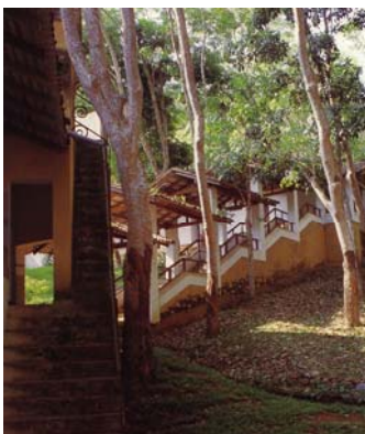
Gambar 2 Koridor yang menghubungkan antar blok bertingkat mengikuti kontur tanpa menebang pohon yang ada (Beng, 1998)
