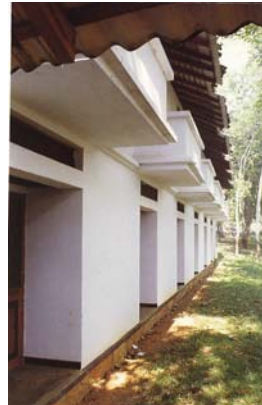
Gambar 21. Penggunaan rangkaian atap overhang (Beng, 1998)
