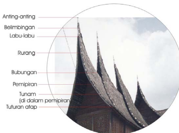
Gambar 4. nama-nama bagian atap Rumah Gadang
