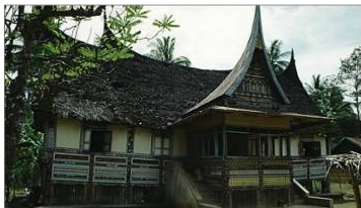
Gambar 27. Rumah Gadang yang memiliki material batu pada pondasinya, kayu pada tiangnya, dan ijuk pada atapnya.
