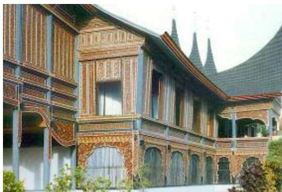
Gambar 29. sasak yang menutupi kolong
